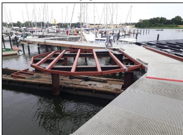
Höhe des Wertgeländes ans Ufer an. Parallel zum Steg sind Heckpfähle gerammt worden. Die Plattformen, auf denen das Bistro sowie das Hafenmeisterbüro errichtet werden sollen, sind im Nahbereich des Ufers entstanden. Sie sind ebenfalls auf Pfählen gegründet.
