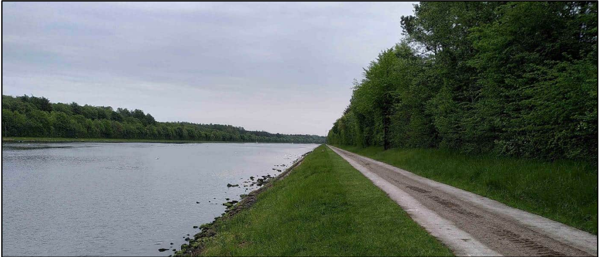
Abbildung 11: NOK mit Gehölz-bestandener Böschung auf der südlichen Seite
