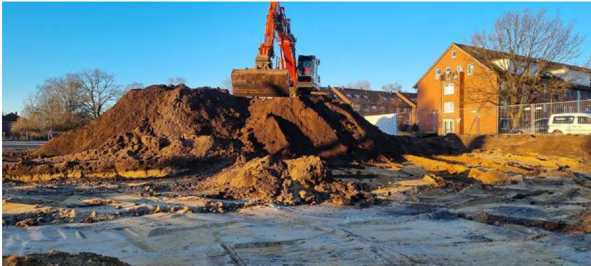
Bild 5: mittlere Grundstücksfläche nach Abtrag der Auffüllungen (Halde 5), Blick gen Südwest, 19.02.2025
