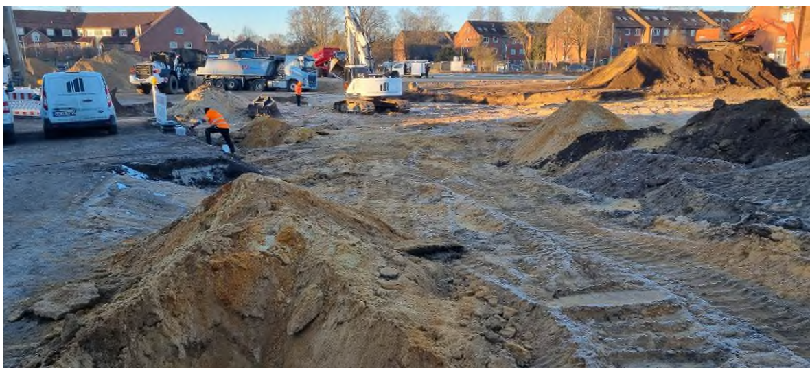
Bild 7: mittlere Grundstücksfläche nach Abtrag der Auffüllungen, Blick gen Süd, 19.02.2025
