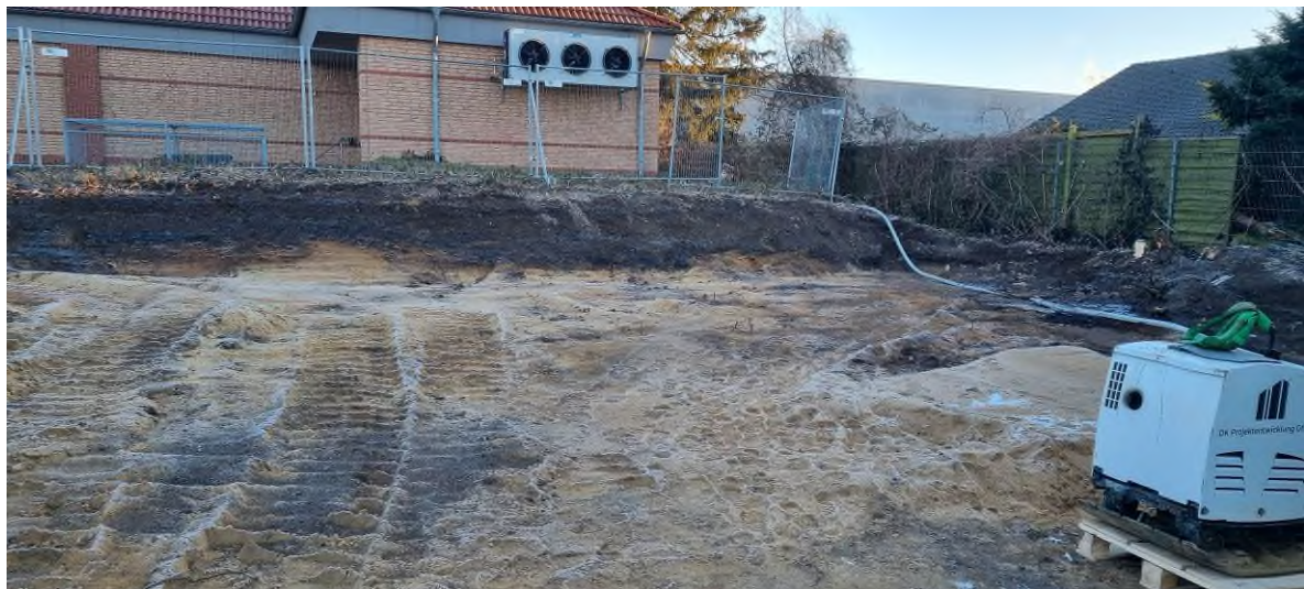
Bild 6: Grundstücksfläche Nordost nach Abtrag der Auffüllungen, Blick gen Nord, 19.02.2025
