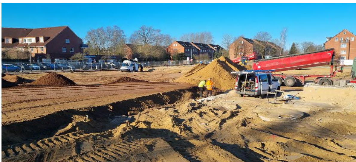
Bild 9: Einbau Füllsande südlicher Bereich, Herstellung GWM, Blick gen Südwest, 19.02.2025
