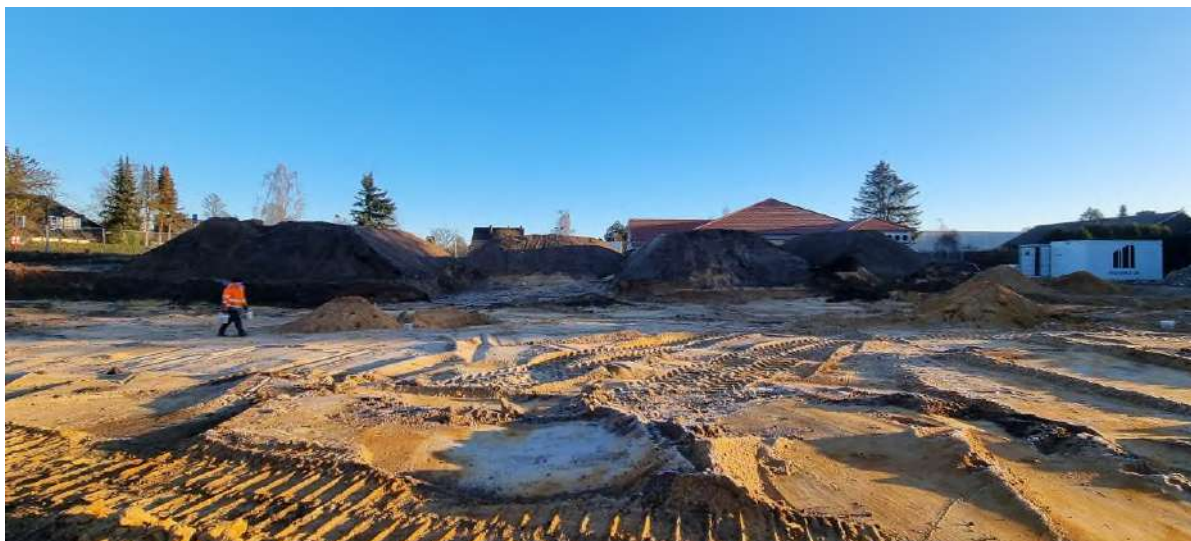
Bild 8: nördliche Grundstücksfläche nach Abtrag der Auffüllungen (Halden 1 bis 4), Blick gen Nord, 19.02.2025
