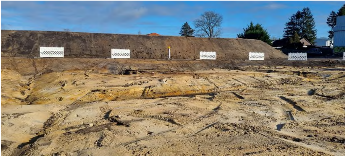
Bild 3: Grundstücksfläche Süd „umwalltes Lager“ etwa mittig des Baufeldes / Bodenhalde, Blick gen Nord, 31.01.2025
