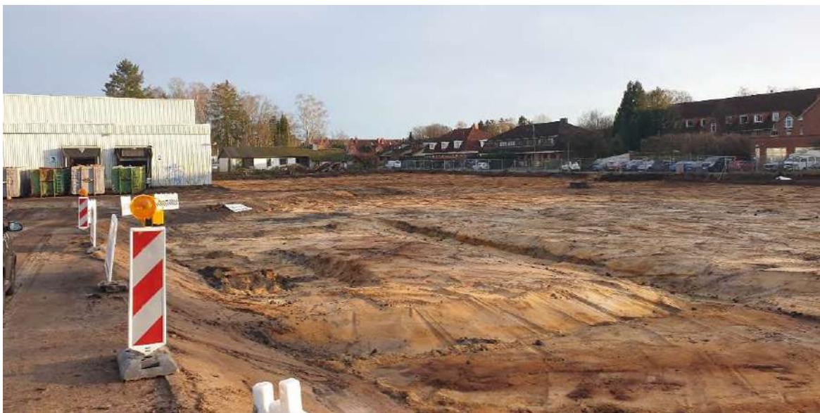
Bild 1: Grundstücksfläche Süd „umwalltes Lager“ etwa mittig des Baufeldes, Blick gen Südost, 31.01.2025
