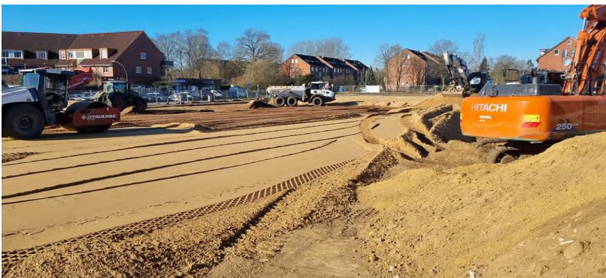
Bild 10: Einbau Füllsande südlicher Bereich, Blick gen Südwest, 19.02.2025
