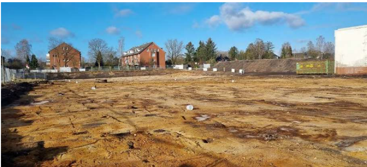
Bild 4: Grundstücksfläche Süd nach Abtrag der Auffüllungen, Blick gen West, 31.01.2025
