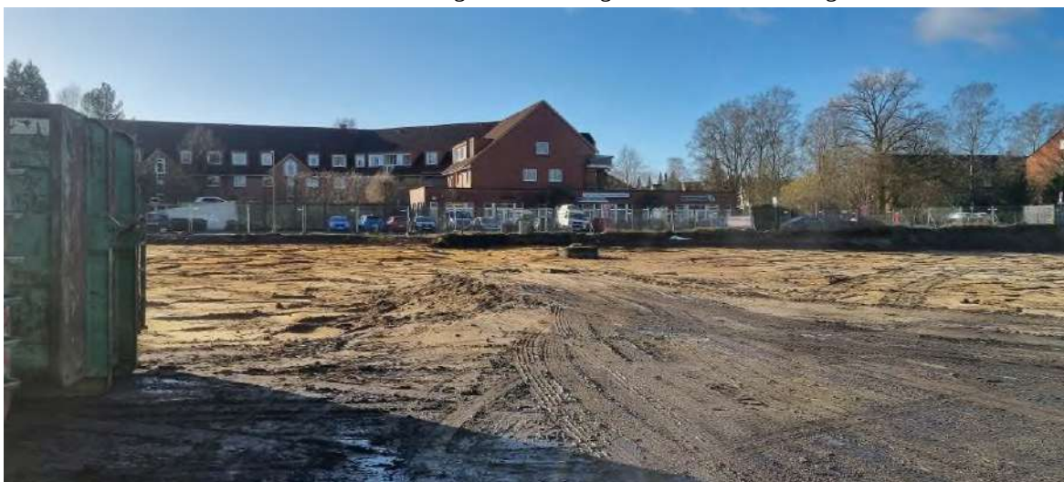
Bild 2: Grundstücksfläche Süd nach Abtrag der Auffüllungen, Blick gen Süd, 31.01.2025
