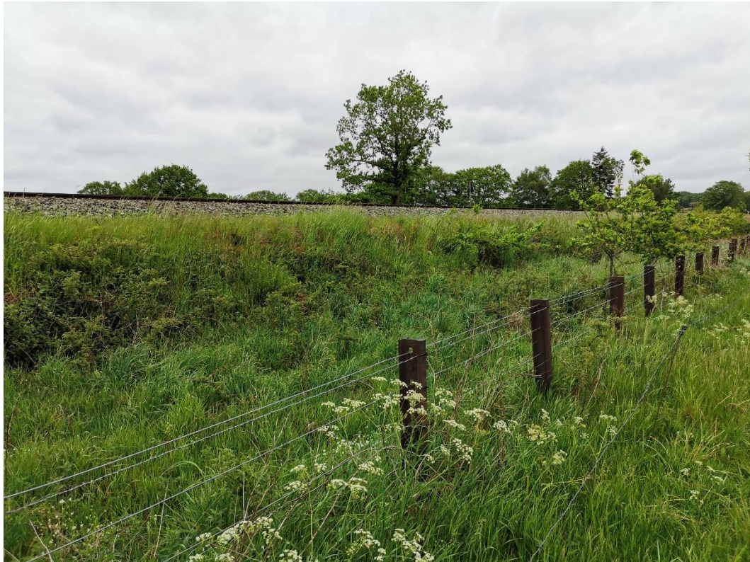
Abbildung 14: Bahndamm nördlich des Plangebietes (Quelle: eigene Darstellung)
