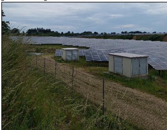
Abbildung 14: Blick von dem Teilgebiet 3 Richtung Nordosten auf den Solarpark Pahlen (Planungsbüro ALSE, 06.06.2024)
