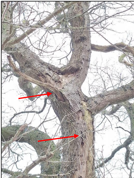
Abbildung 30: Risse und Spalten in einer Stieleiche entlang der westlichen Grenze des Teilgebietes 3, Baumnr. 83 (Planungsbüro ALSE 12.03.2024)
