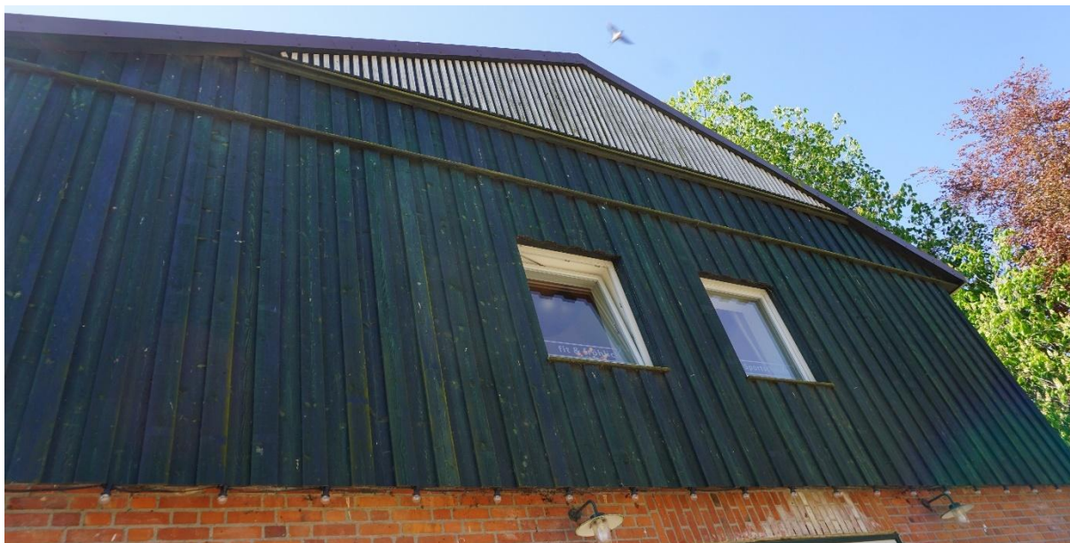
Abbildung 12: fledermausfreundliche Fassade am Gastronomiegebäude/ Sportscheune
