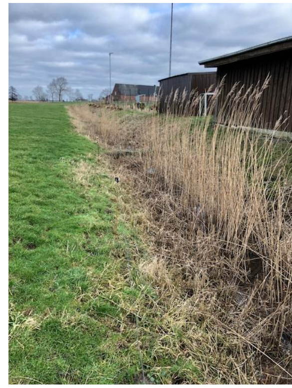
Photo 3: Östlicher Graben Blickrichtung Nord
