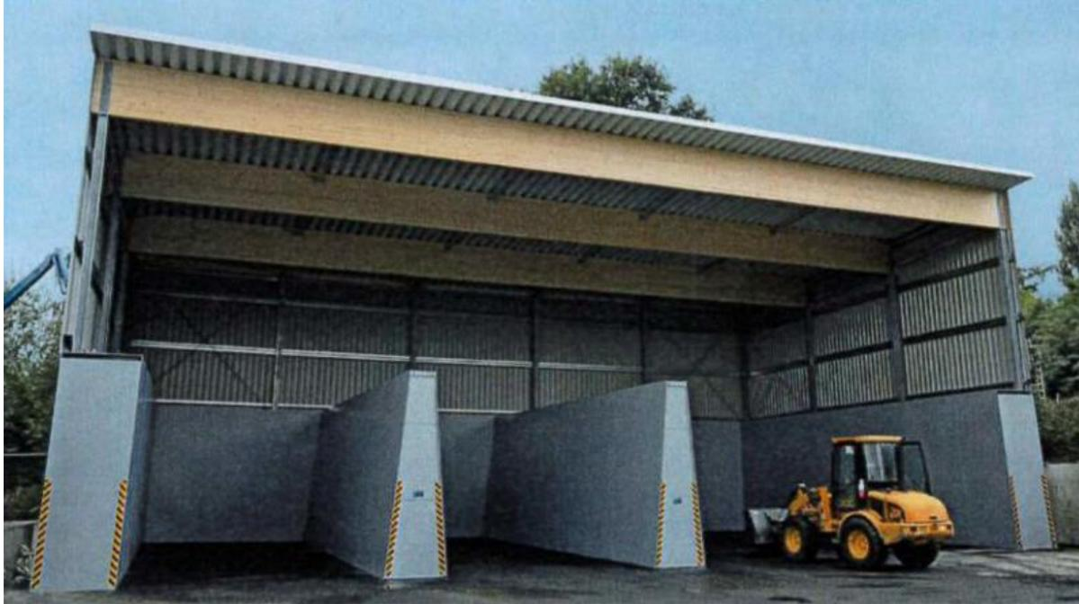
Abb. 4: Beispiele erforderlicher Schüttgutlagerhallen (1), Quelle: Vereinigte Asphaltmischwerke GmbH & Co KG
