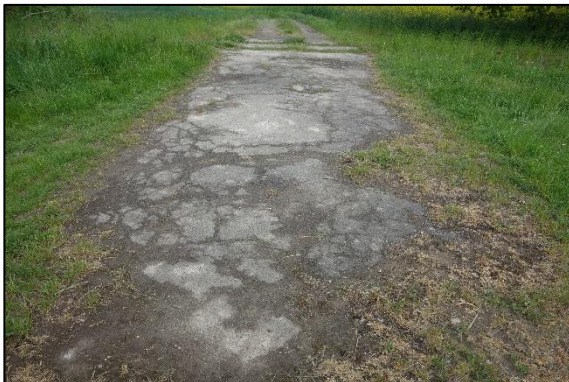
Abbildung 7: Asphaltierter Abschnitt eines Feldweges (ALSE 17.05.2023)
