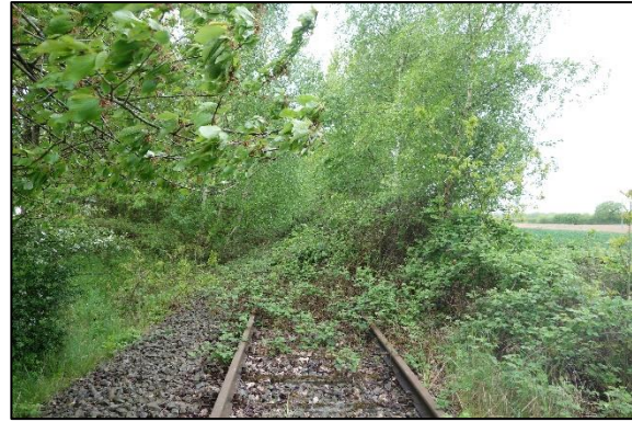
Abbildung 9: Eingewachsenes Bahngleis (ALSE 17.05.2023)
