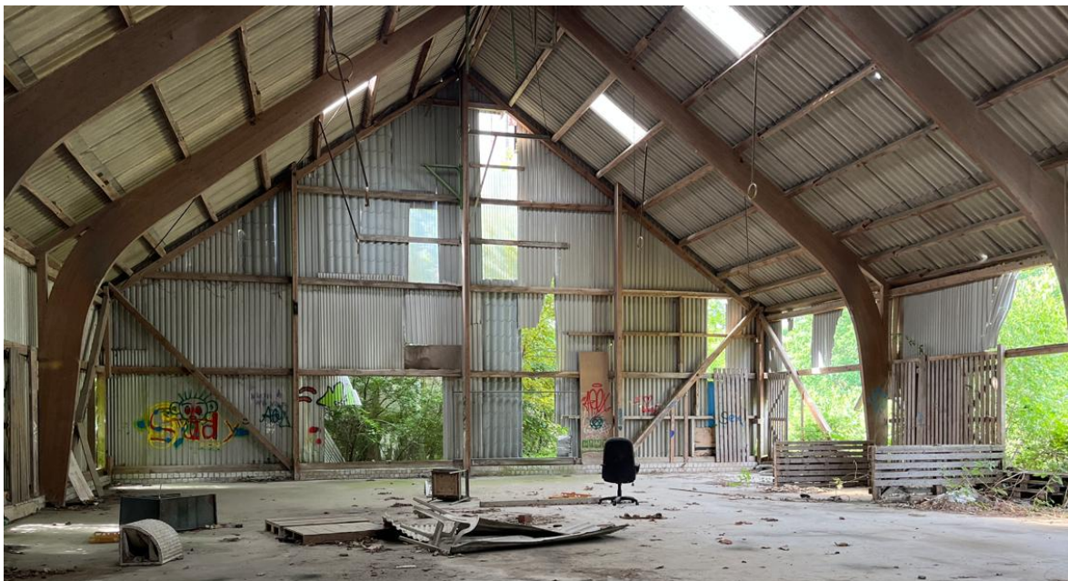
Halle in Metallbauweise
