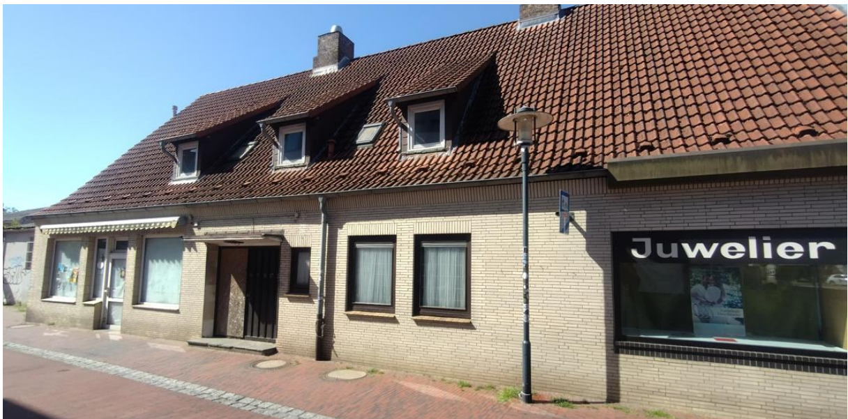
Foto 2: Wohn- und Gewerbebebauung, Klinkermauerwerk und Dach intakt.
