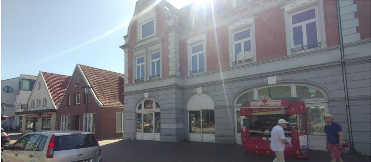
Foto 1: Frontseite und Hauptgebäude mit weitgehend intakter Fassade, kleinere Wohnhäuser links.
