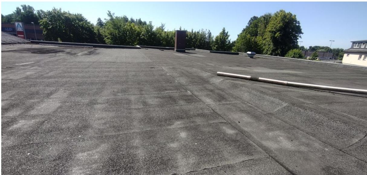
Foto 6: Dachfläche ohne Spuren von z.B. Möwennestern.
