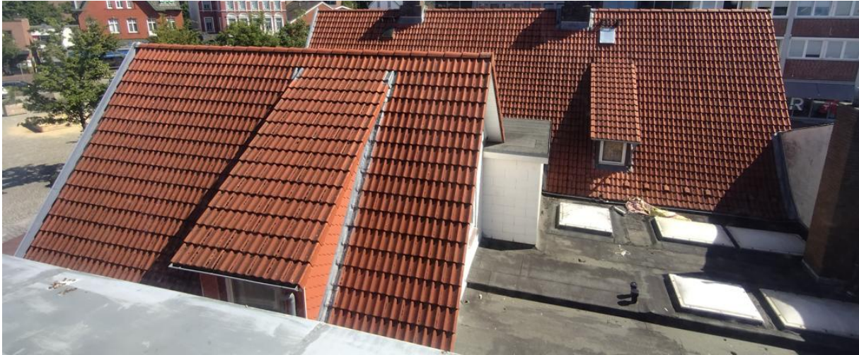
Foto 5: Dachflächen weitgehend intakt bieten keine Möglichkeiten für Wochenstuben der Fledermäuse, einzelne Tagesquartiere sind nicht auszuschließen.
