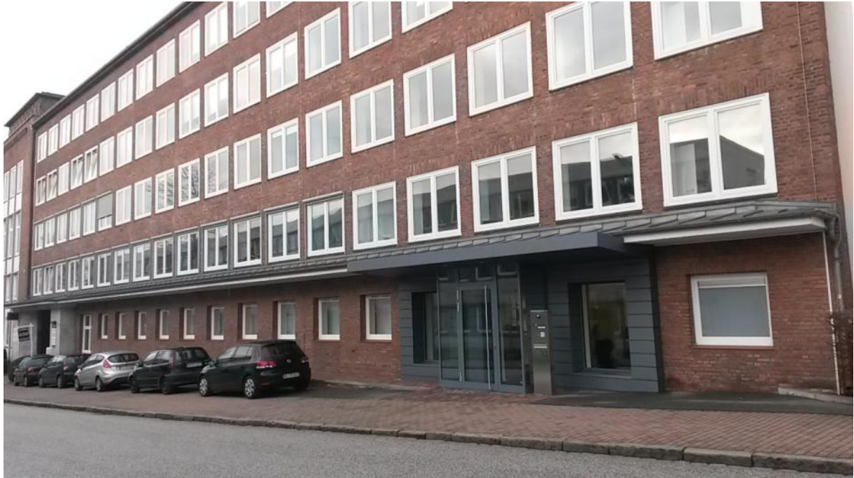
Foto 7: Hafenstraße 32 – 32b (Bürogebäude) von Nordosten
