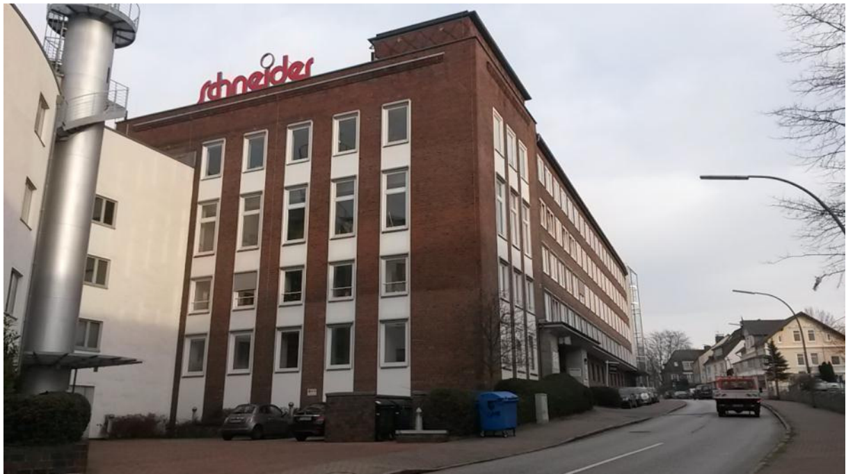
Foto 8: Hafenstraße 32 – 32b (Bürogebäude) von Süden
