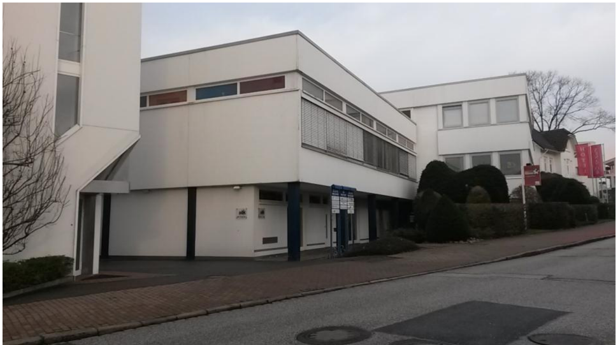
Foto 4: Hafenstraße 28a (Restaurant, Tanzschule) von Südosten
