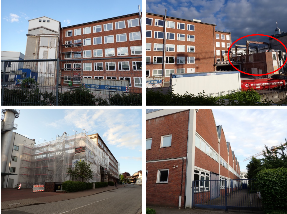
Abbildung 2: Gebäude an der Hafenstraße (Jobcenter, Hafenstraße 32) nördlicher Abschnitt Hinteransicht mit Sicht auf das abgerissene Gebäude (Hafenstraße 32b) im Norden (oben links, Hafenstraße 32, 32a, BT-C und BT-B), Gebäude an der Hafenstraße (Jobcenter) Hinteransicht südlicher Abschnitt mit Blick auf das Teilabrissgebäude im Süden (rot markiert, oben rechts, Hafenstraße 32, 32b, BT-B und BT-A), Ansicht der Gebäudekomplexes von der südlichen Hafenstraße aus (unten links, BT-A und BT-B), Hinteransicht der Sheddach-Halle im Westen der Plangebietes (unten rechts)
