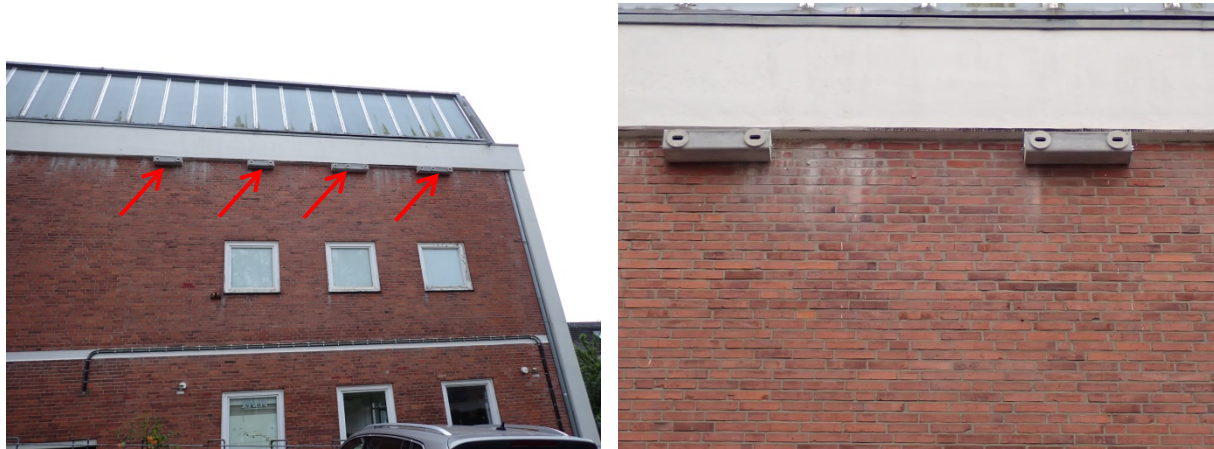
Abbildung 5: Die zehn Mauerseglerbrutkammern verteilt auf vier Kästen an der Nordfassade der Sheddach-Halle (links), Detailaufnahme der zwei linken Kästen mit je zwei Brutkammern
