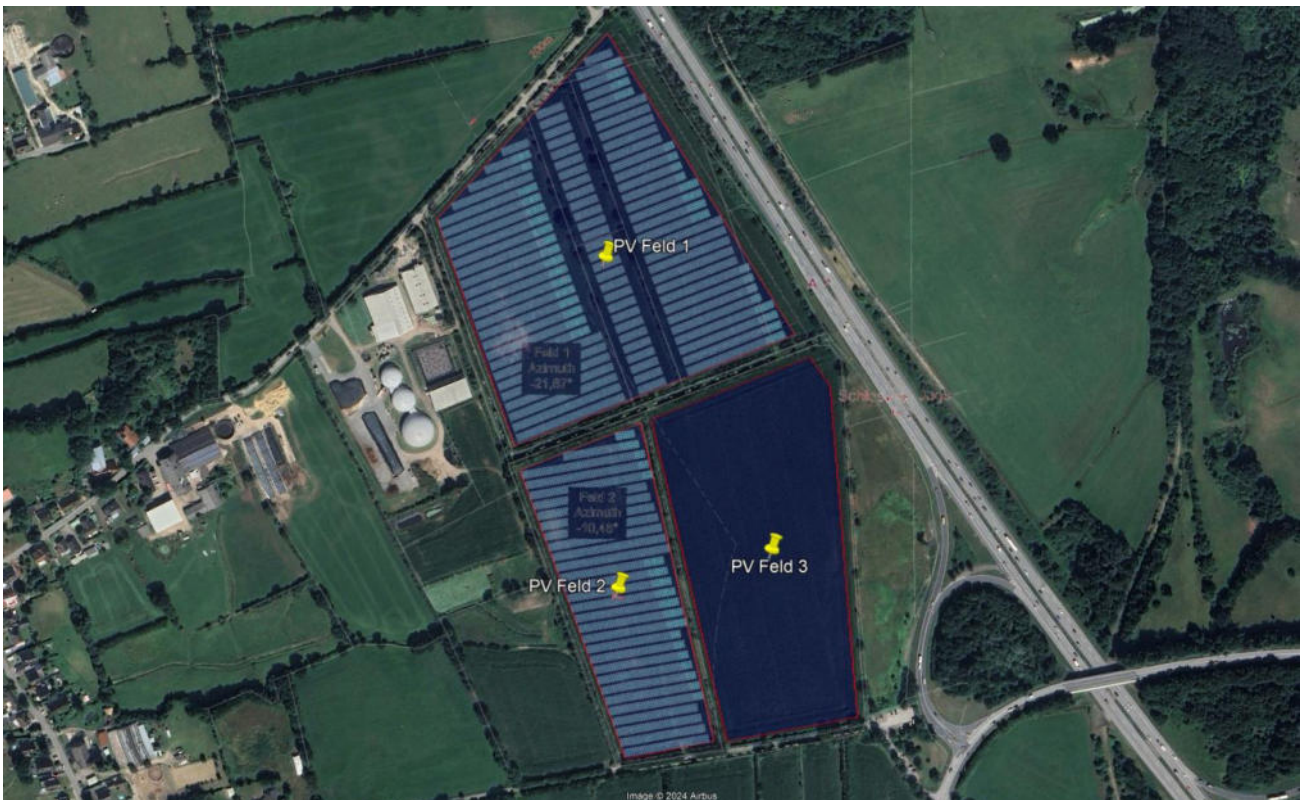
Bild 2.1.3: Detailansicht der PV-Flächen (Quelle: Google Earth/SolPEG)
