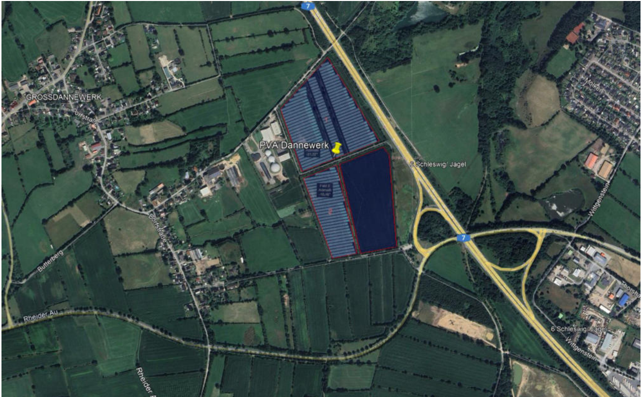
Bild 2.1.2: Detailansicht der PV-Flächen (Quelle: Google Earth/SolPEG)
