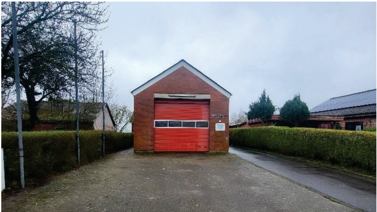
Foto 10: Bestehendes Feuerwehrgerätehaus südlich der L 142
