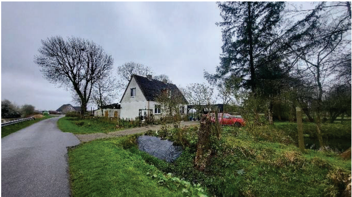
Foto 12: Straße im Südosten des Geltungsbereiches und anliegende Gebäude, z.T. verfallen, Blick in Richtung Süden
