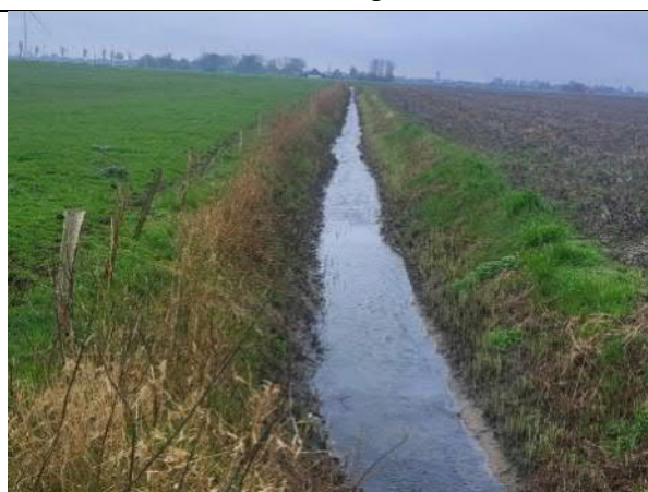
Entwässerungsgraben im Norden des Plangebiets (außerhalb des Geltungsbereichs)
