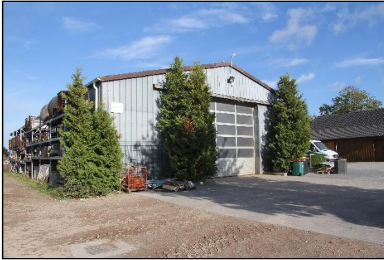
Maschinenhalle Ansicht Ost
