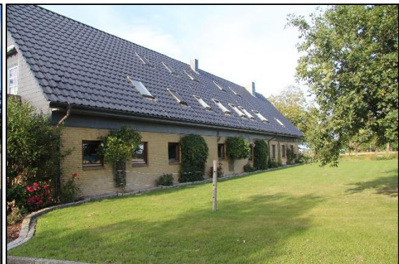
Wohngebäude Ansicht Süd
