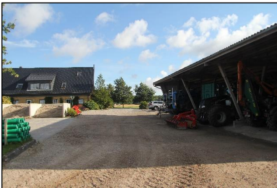
Maschinenhalle im westlichen Bereich
