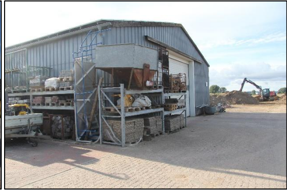
Maschinenhalle Ansicht West mit Lagerregal
