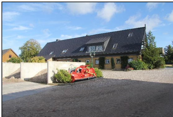
Wohngebäude Ansicht Nord
