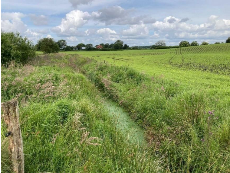
Abb. 20: Entwässerungsgraben direkt westlich des Moorkomplexes, Blick nach N
