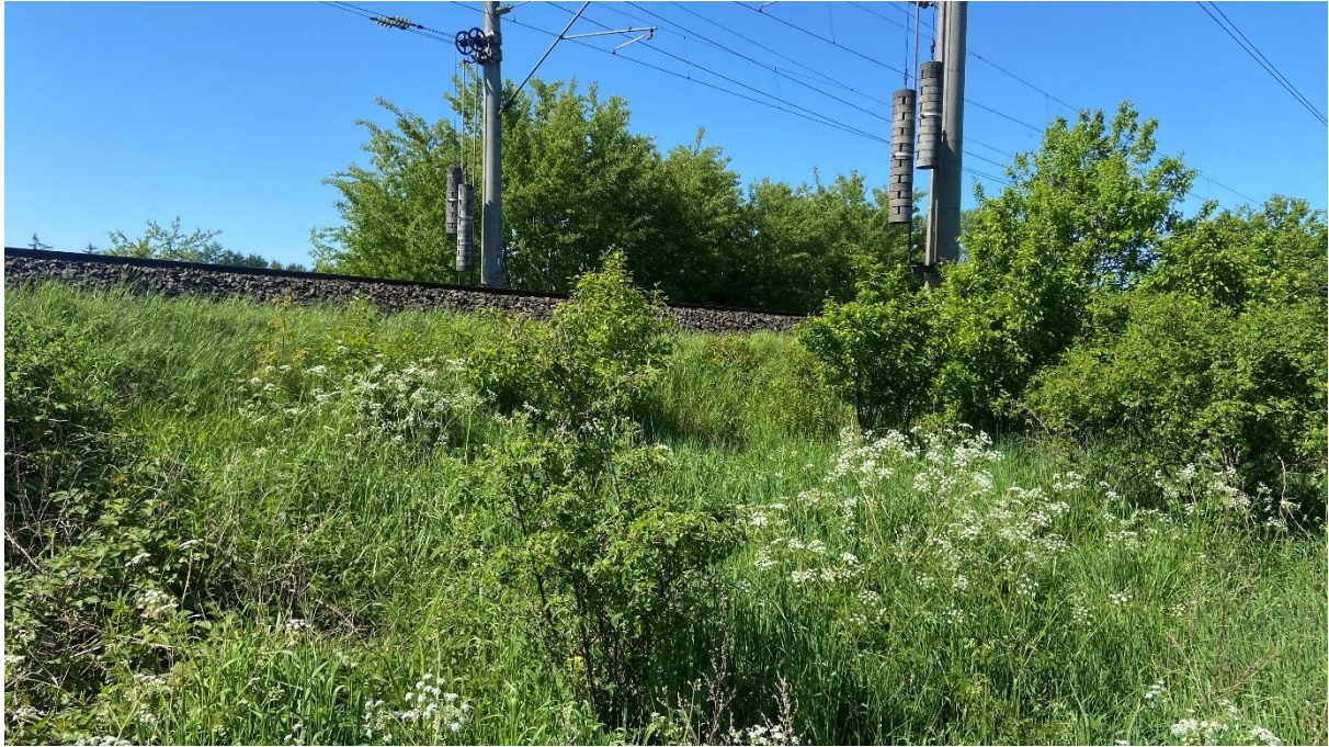
Foto 9: Bahnböschung im Übergang zur Teilfläche 1. Blickrichtung Südwesten.
