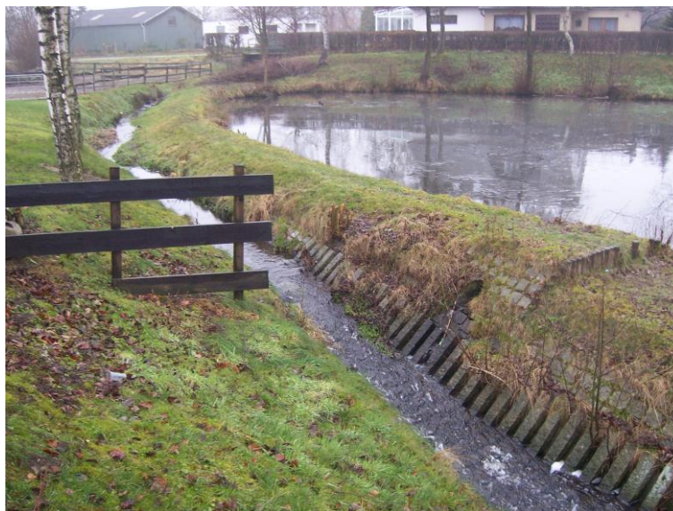
Abbildung 1 Einleitstelle „A“ mit Rückhaltebecken
