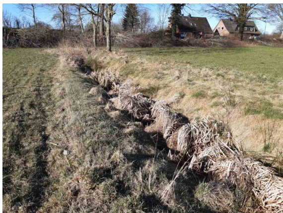
Graben am nordwestlichen Rand
