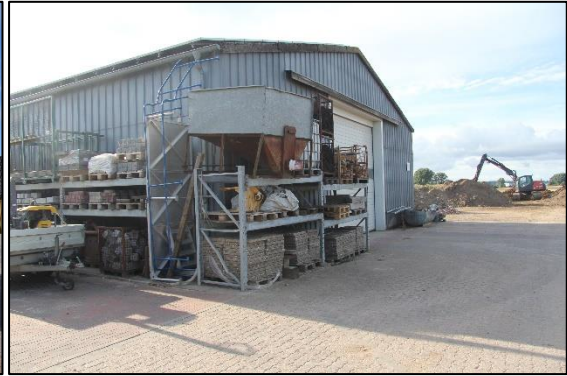
Maschinenhalle Ansicht West mit Lagerregal
