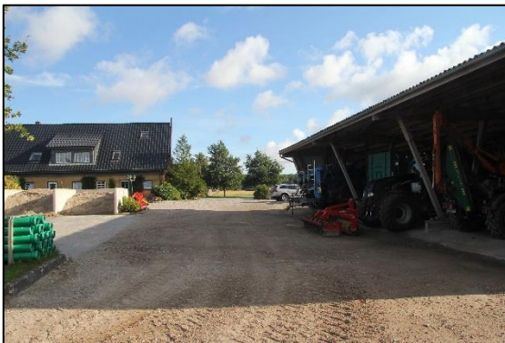
Maschinenhalle im westlichen Bereich
