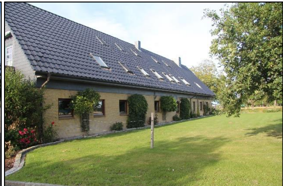
Wohngebäude Ansicht Süd
