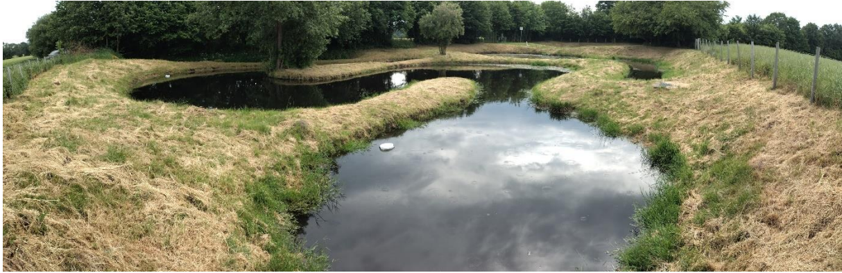
Foto 14: Nördlich der Teilfläche 3 gelegene Regenklär- bzw. Regenrückhaltebecken. Blickrichtung Südwesten.
