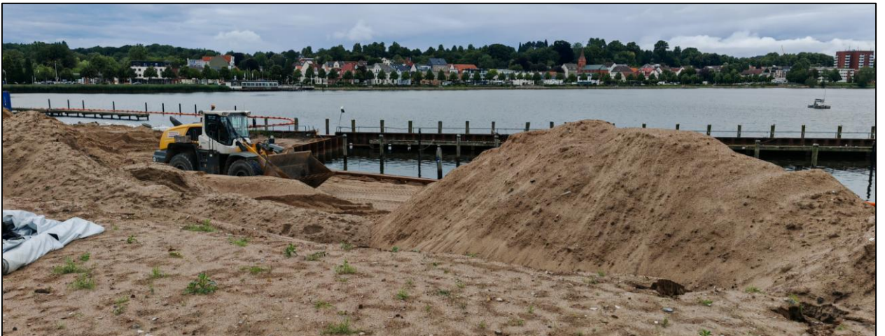
Abb. 5: Sanierungsbaustelle nördlich der Callisenstraße
