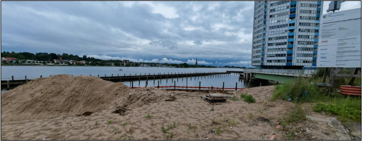
Abb. 2: Blick auf den Nordhafen (wegen der Sanierungsarbeiten ohne Sportboote)
