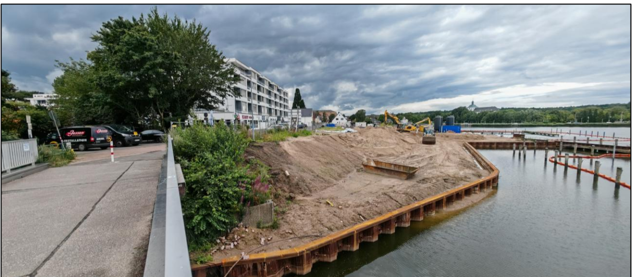
Abb. 7: Sanierungsbaustelle nördlich der Callisenstraße
