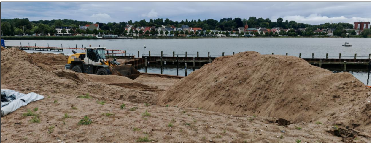
Abb. 6: Sanierungsbaustelle nördlich der Callisenstraße
