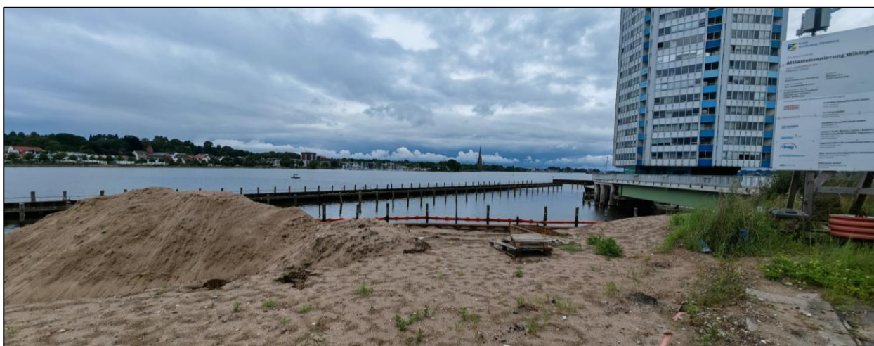
Abb. 3: Blick auf den Nordhafen (wegen der Sanierungsarbeiten ohne Sportboote)
