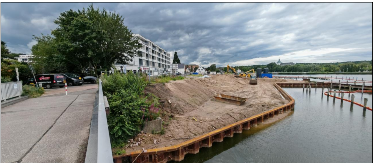
Abb. 6: Sanierungsbaustelle nördlich der Callisenstraße
