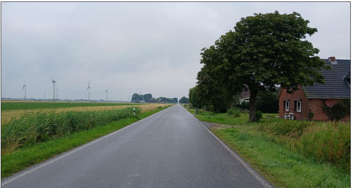
Abbildung 21: Verkehrsstraße („K10“, SVs) und angrenze Wohnbebauung (SDe) im nordwestlichen UG, Blickrichtung Nordwest
