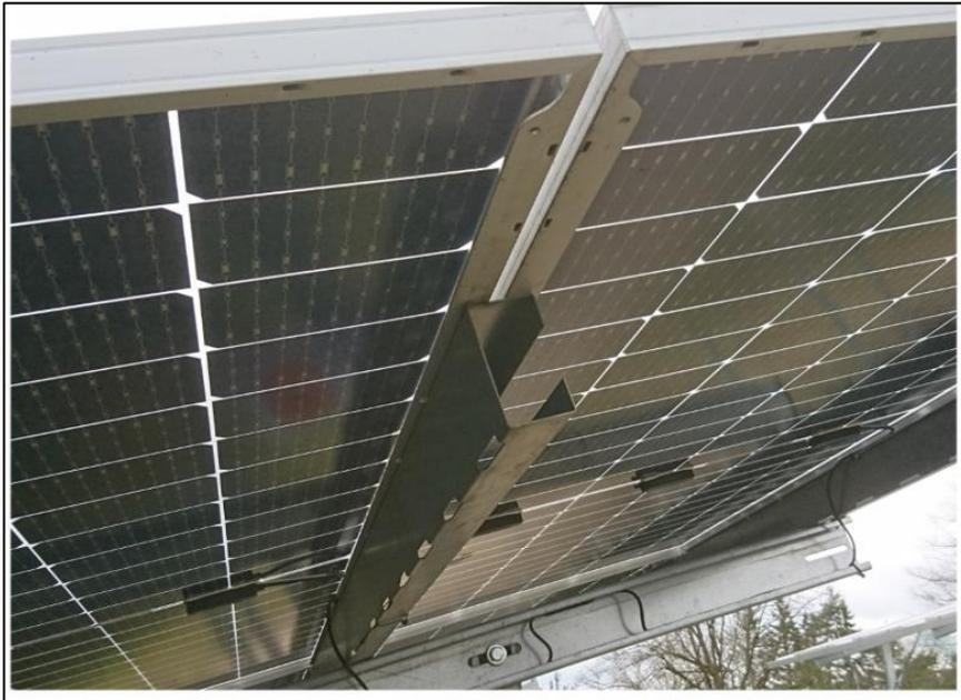
Abbildung 20: patentiertes Regenwasserverteilsystem von SUNfarming (Foto: SUNfarming 2024)
