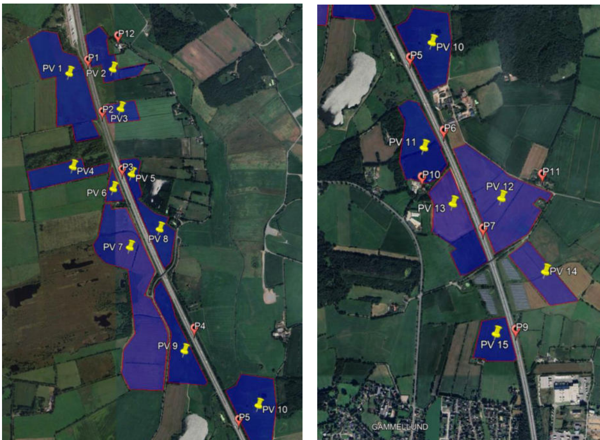
Bild 3.5.1: Übersicht über die PV-Anlage und Messpunkte (Quelle: Google Earth/SolPEG)
