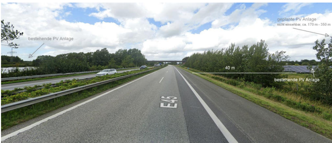
Bild 4.6.1: Foto am Messpunkt P8, Fahrt Richtung Nordwesten (Quelle: Google StreetView, August 2023, Ausschnitt)
