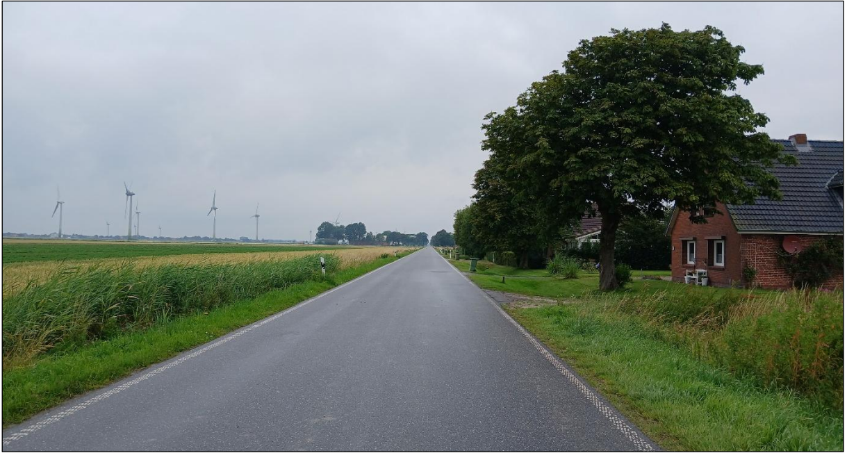
Abbildung 22: Verkehrsstraße („K10“, SVs) und angrenze Wohnbebauung (SDe) im nordwestlichen UG, Blickrichtung Nordwest
