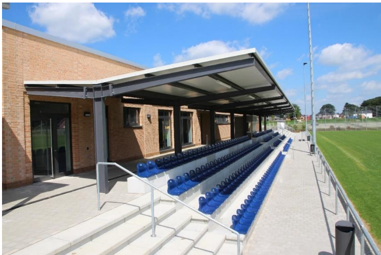
Foto 4: Beispiel Zuschauerbereich mit Wetterschutz
