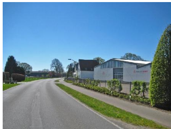
Abb. 3c Blick auf die Bebauung an der westlichen Straßenseite der Rosenstraße
