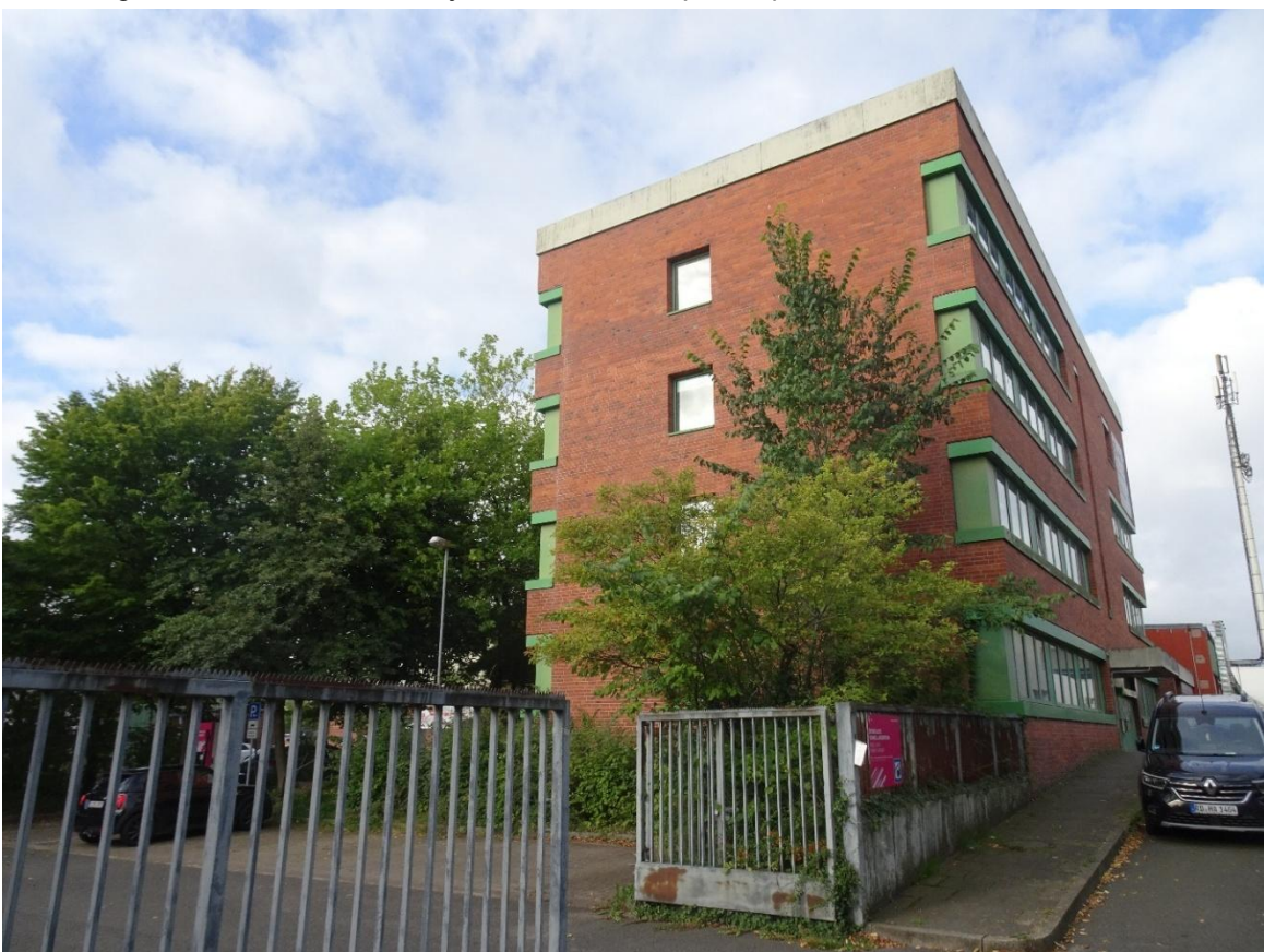
Abbildung 15: Gebäude am Flurstück 46/16
