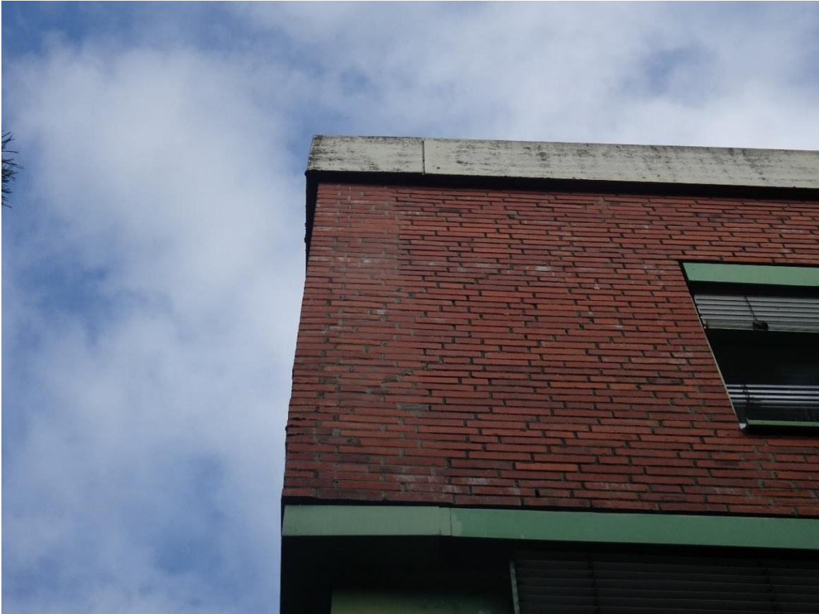
Abbildung 16: Dachbereich von Gebäude auf Flurstück 46/16
