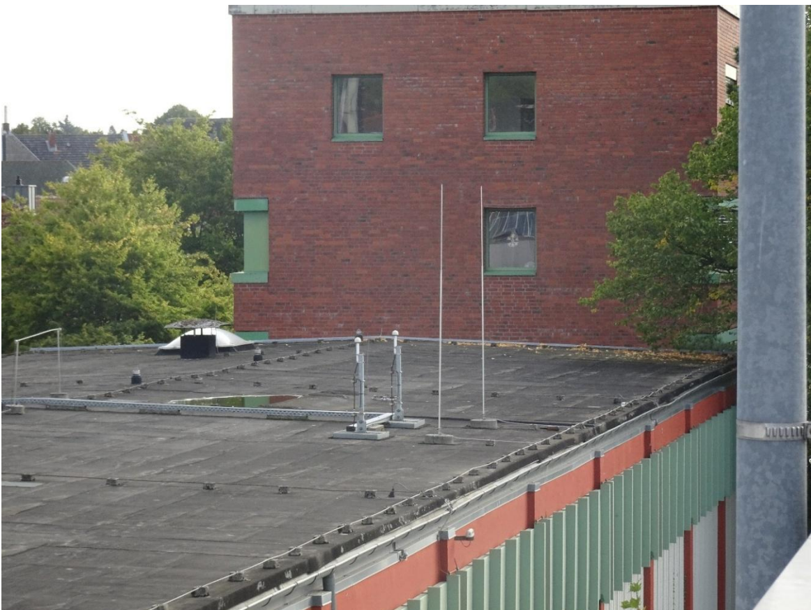
Abbildung 7: Dach von Königstraße 20
