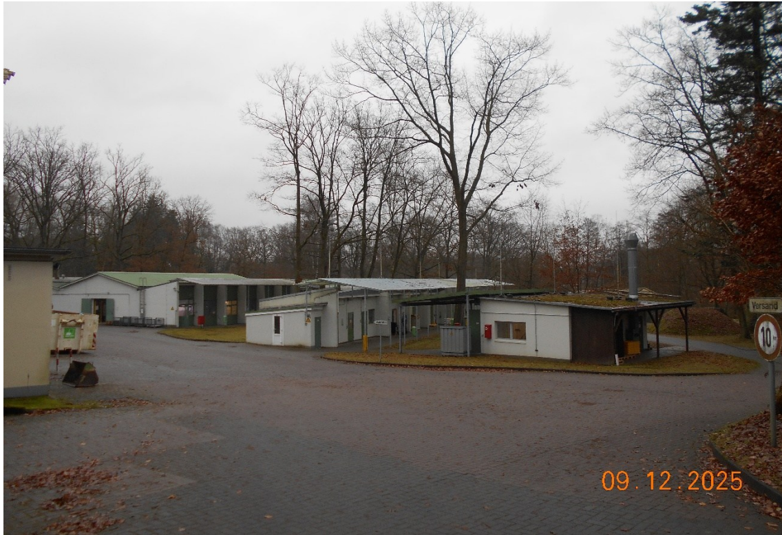
Abbildung 1 Betriebsgebäude südlich der Verwaltungsgebäude
