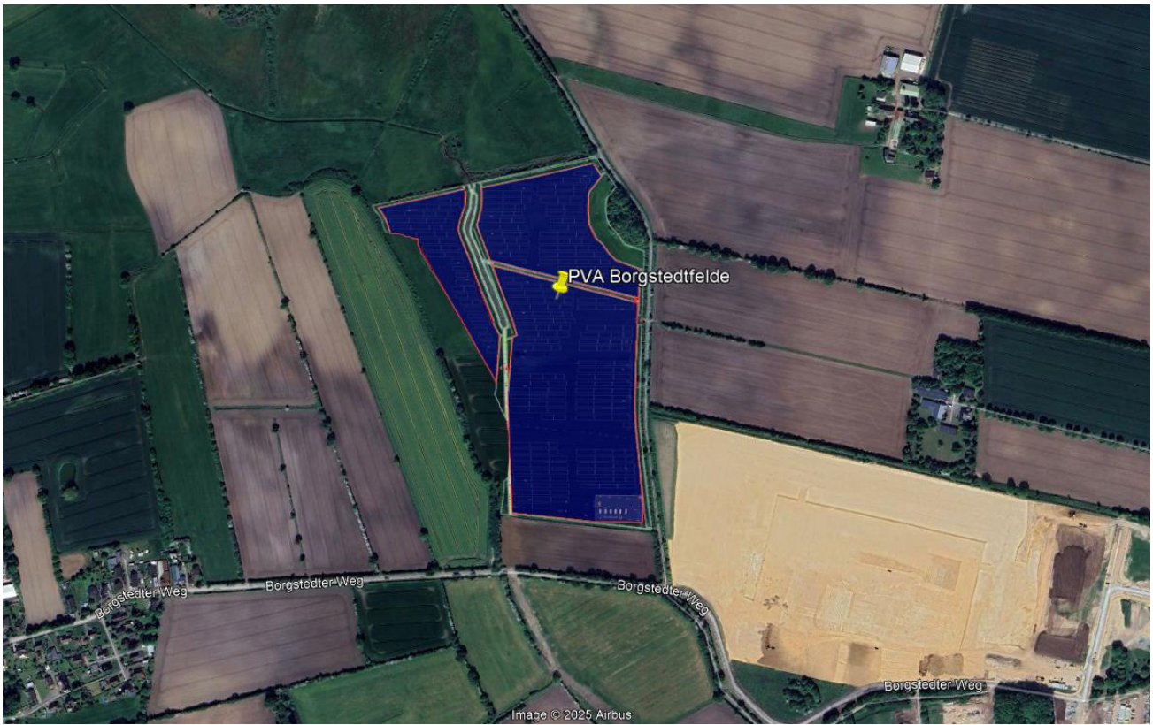
Bild 2.2: Luftbild der PV-Anlage (Quelle: Google Earth / SolPEG)
