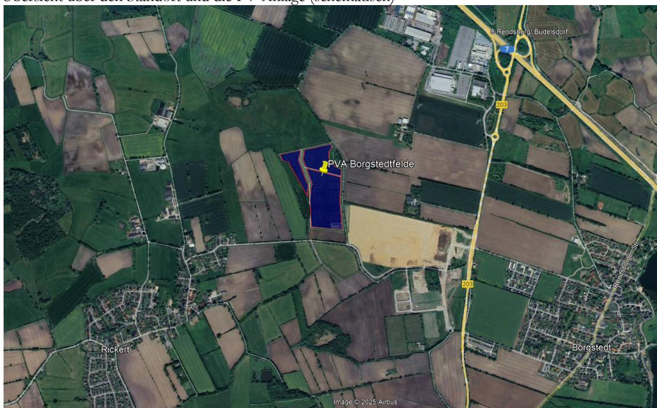
Bild 2.1: Luftbild der PV-Anlage (Quelle: Google Earth / SolPEG)
